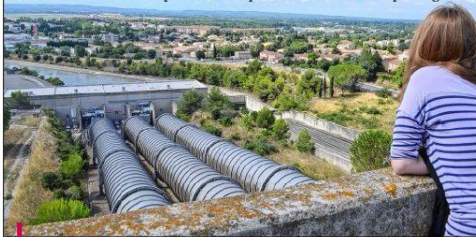
Du haut du barrage les trois énormes tuyaux, de 5 m 60 de diamètre, rejettent l'eau en faisant tourner les turbines de la centrale. / PHOTO F.G.
