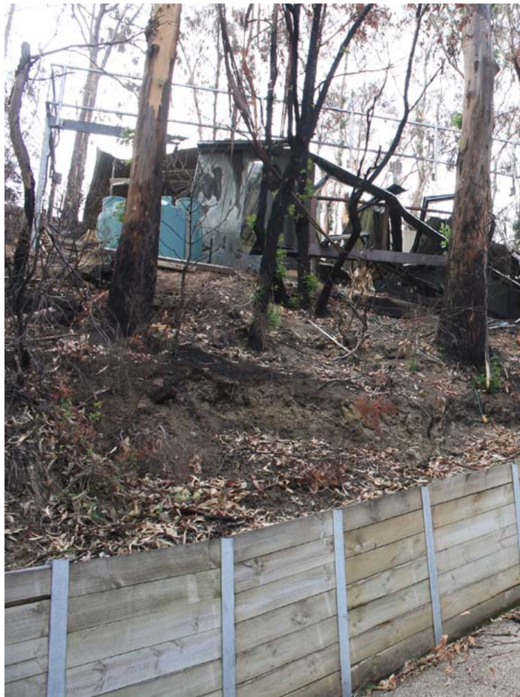
Kvarlevorna av ett av de 116 hus som brann ner i Wye River, 16 mil sydväst om Melbourne, på juldagen.
