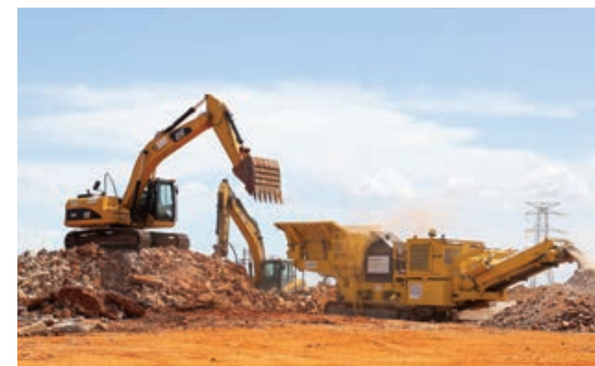
Reciclagem de resíduos de concreto na UFN-III, em Três Lagoas (MS): reaproveitamento e economia
